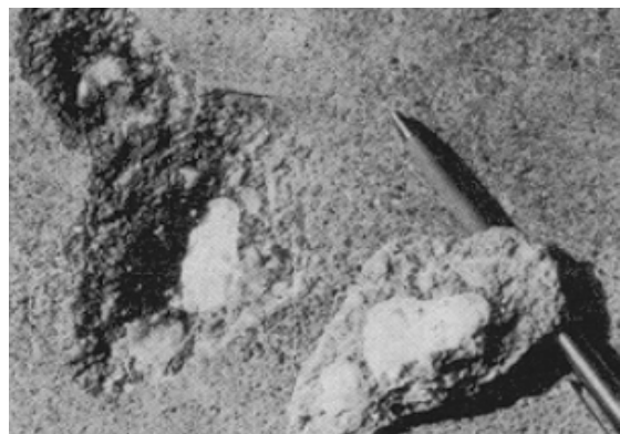
Spalling
