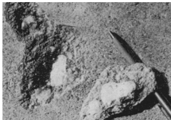
Spalling
